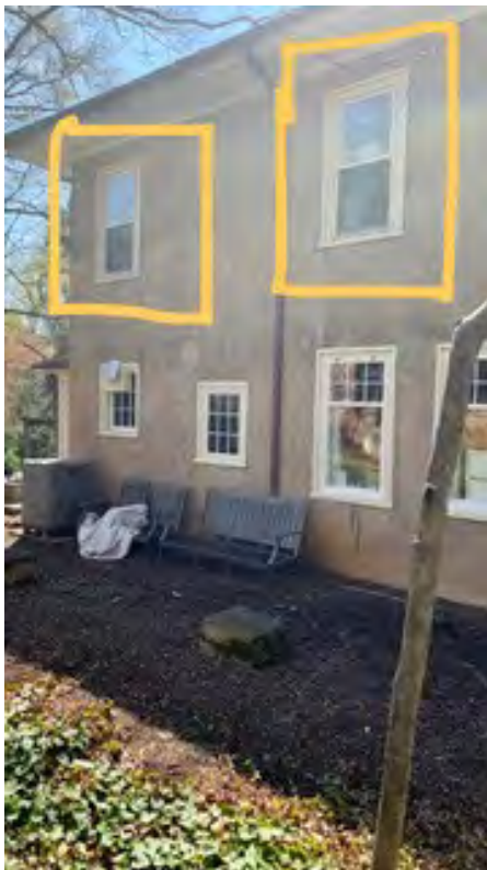
Rear - SE Corner
