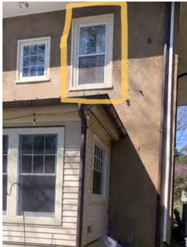
Rear - NE Corner
