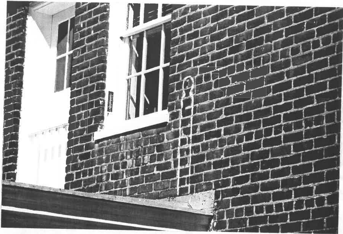
EXISTING UPPER PORCH DOOR
