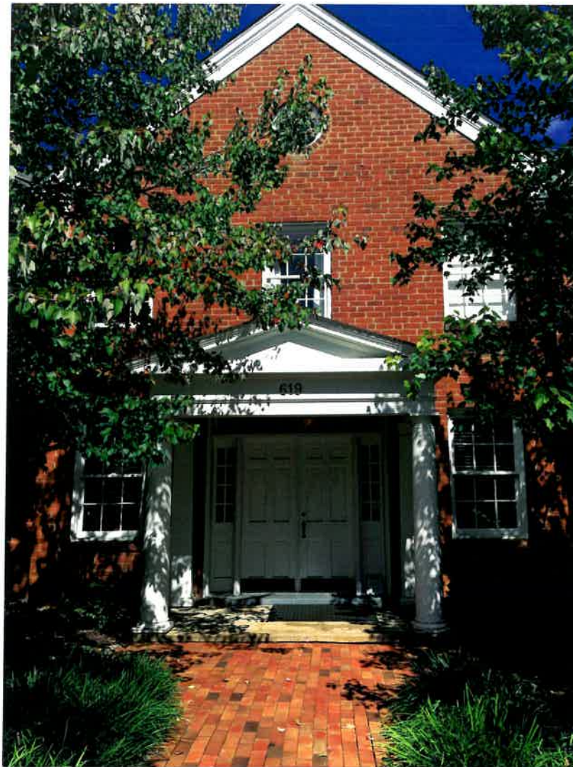
619 E. HIGH ST, SOUTH FACADE (SUBJECT PROPERTY)
