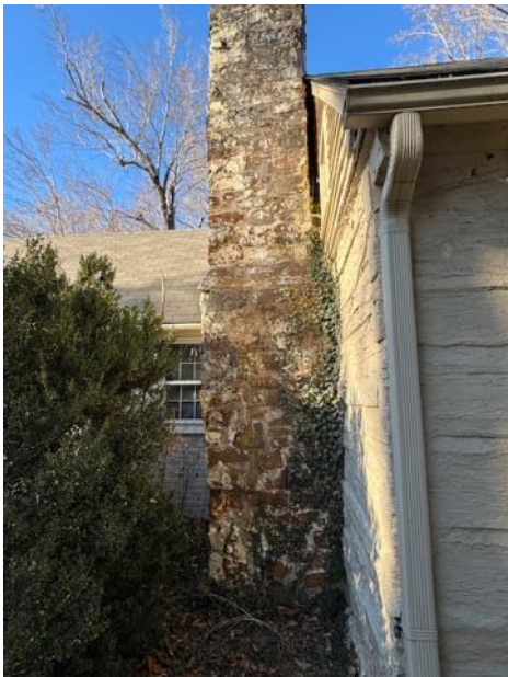
STONE CHIMNEY - LEFT
