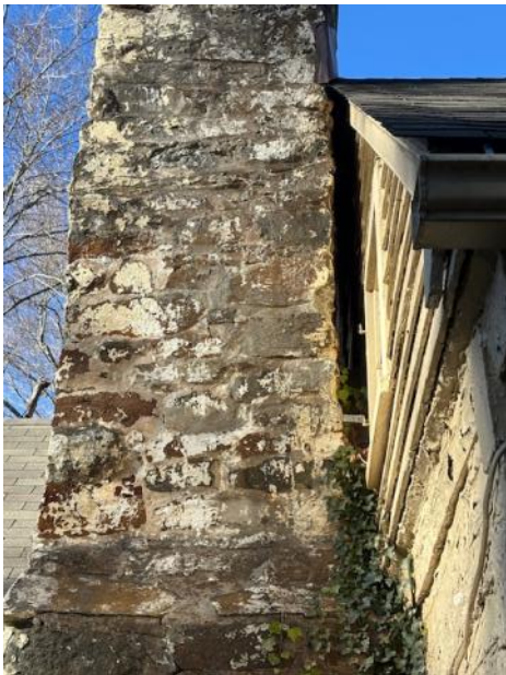
STONE CHIMNEY - LEFT
